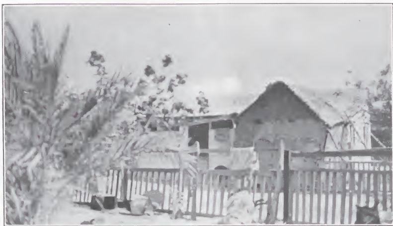
Leemen hut met erfje * House of loam * Cabana de lodo
